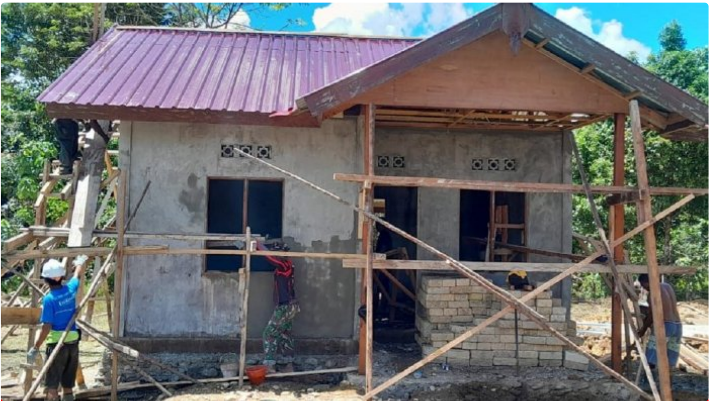
Terlihat bangunan Rumah Pastori Tipe 36 Yang Sudah Rampung 78 Persen
